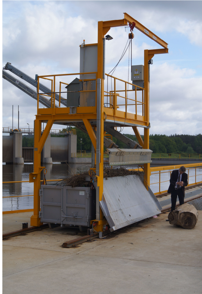
Fot.6. Projekt i wykonanie przejazdnej automatycznej czyszczarki krat na jaz Krzywaniem
