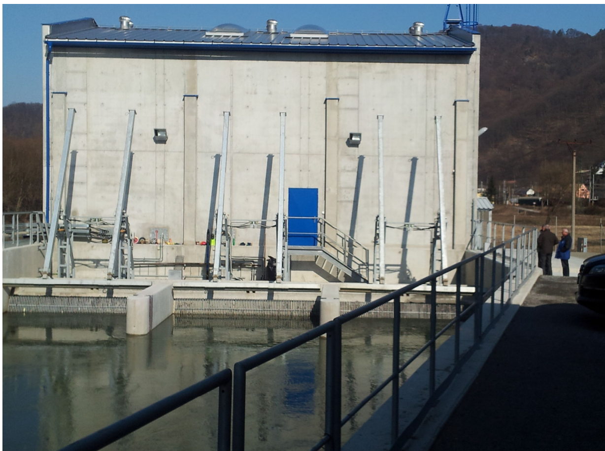
Fot.3. Projekt i wykonanie trzech podwójnych czyszczarek na EW Hronská Dubrava Słowacja
