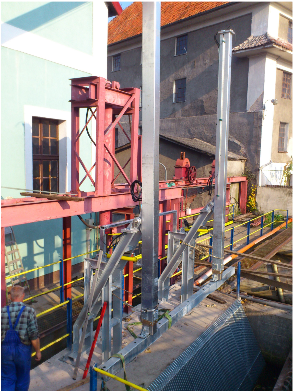
Fot.5. Projekt i wykonanie automatycznej czyszczarki krat na EW Lidzbark Warmiński I i II
