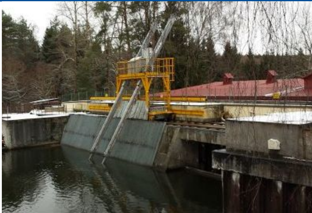
Fot.7. Projekt i wykonanie przejazdnej automatycznej czyszczarki krat na EW Brąswald
