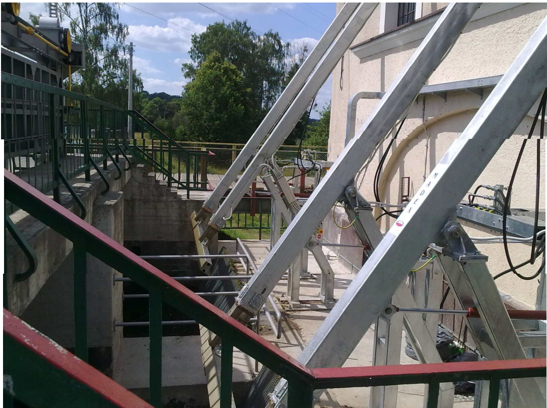
Fot.2. Projekt i wykonanie dwóch podwójnych czyszczarek na EW Krzyna
